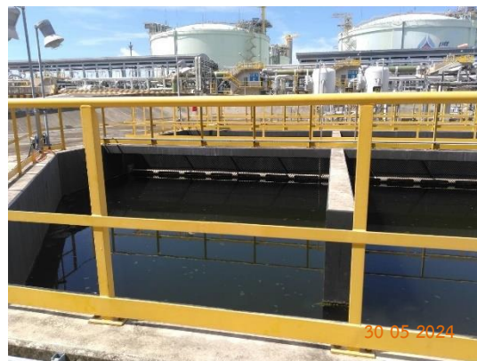
รูปที่ 1-7 ระบบ CPI Separator
